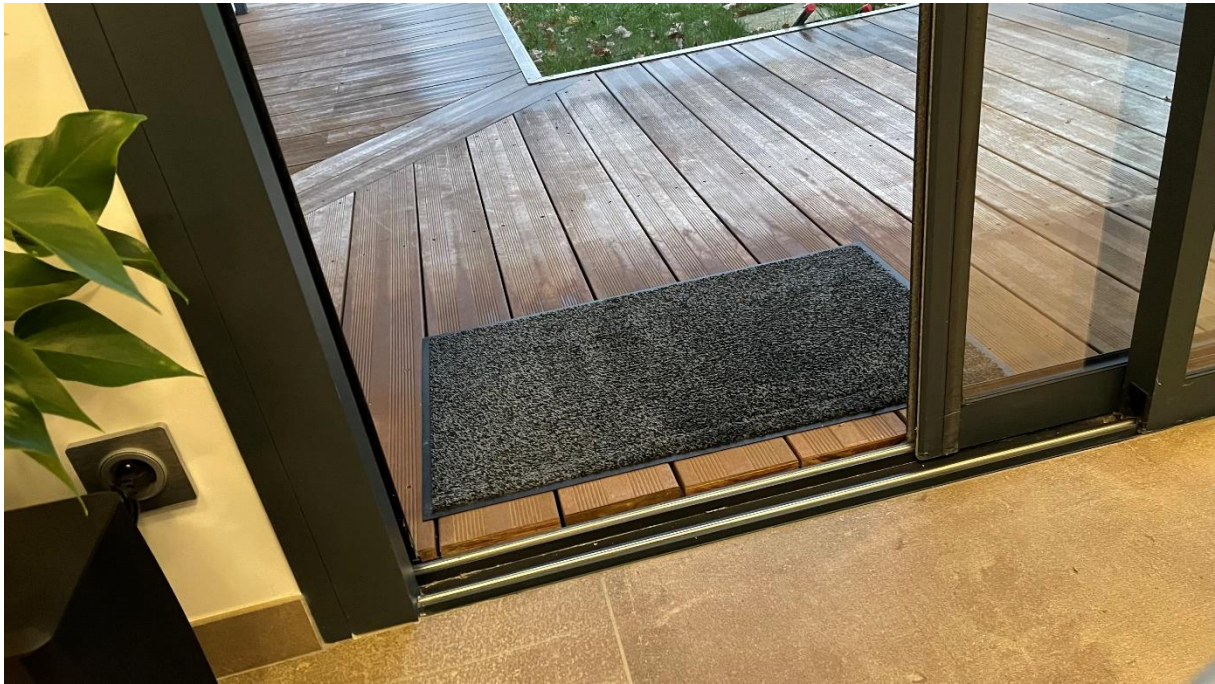
Maison de Marc : seuil de la baie vitrée donnant sur le jardin
